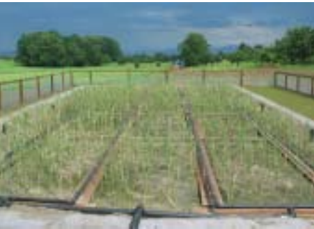
Frisch gesetzte Pflanzenkläranlage
