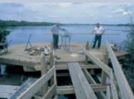
Bau des Herons Carr Bohlenwegs in den Broads
